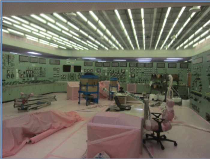
Figure 27. Salle de commande centrale des tranches n°1 et 2, le 22 septembre 2011 (Crédit : Tepco)
