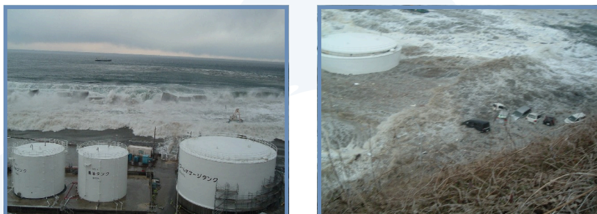
Figure 12. Arrivée du tsunami sur des réservoirs d'eau de la centrale de Fukushima Daiichi - mars 2011 (Crédit : Tepco)
