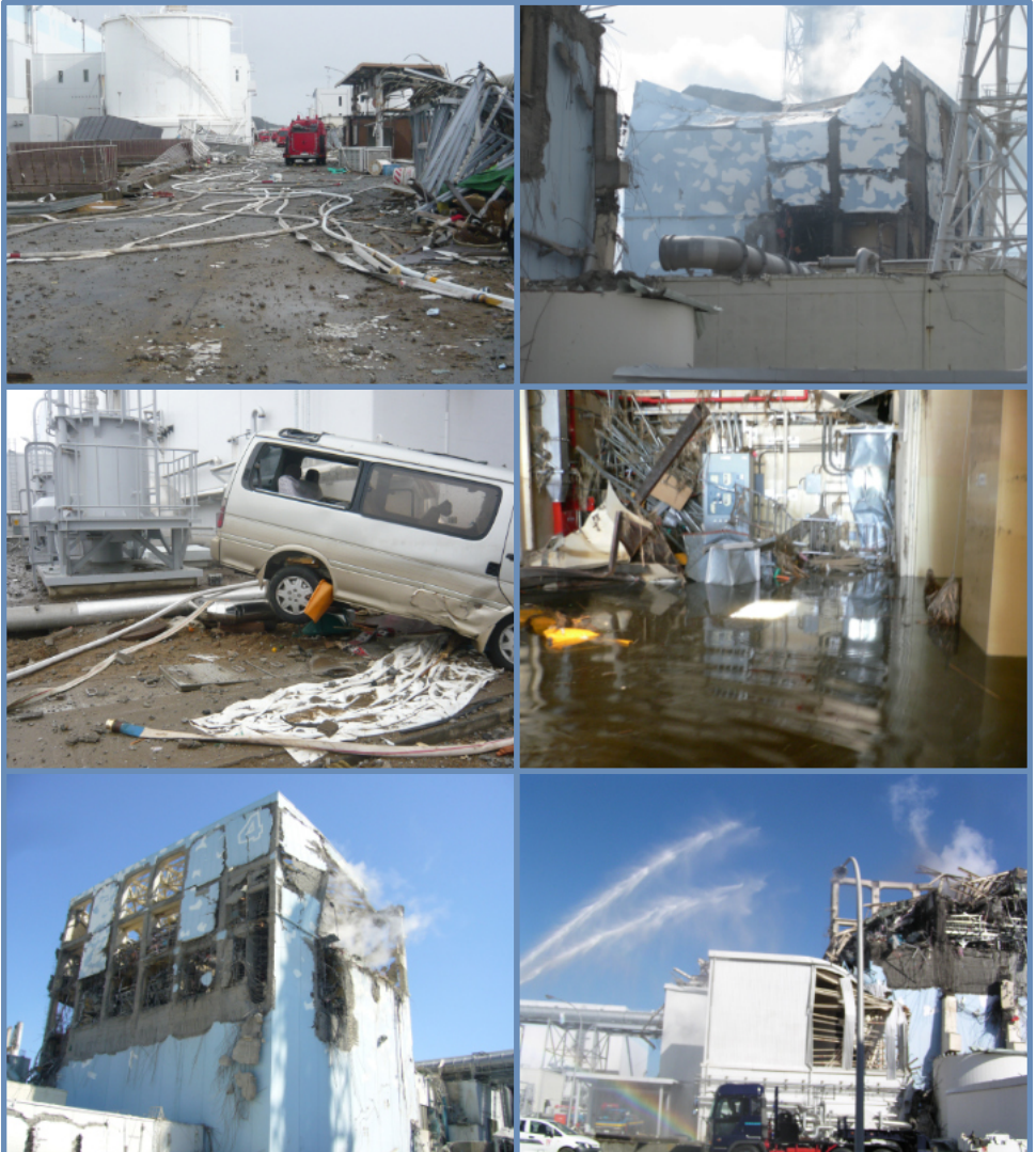
Figure 2. Photos des installations de la centrale nucléaire de Fukushima Daiichi quelques heures et jours après le tsunami (Crédit : Tepco)
