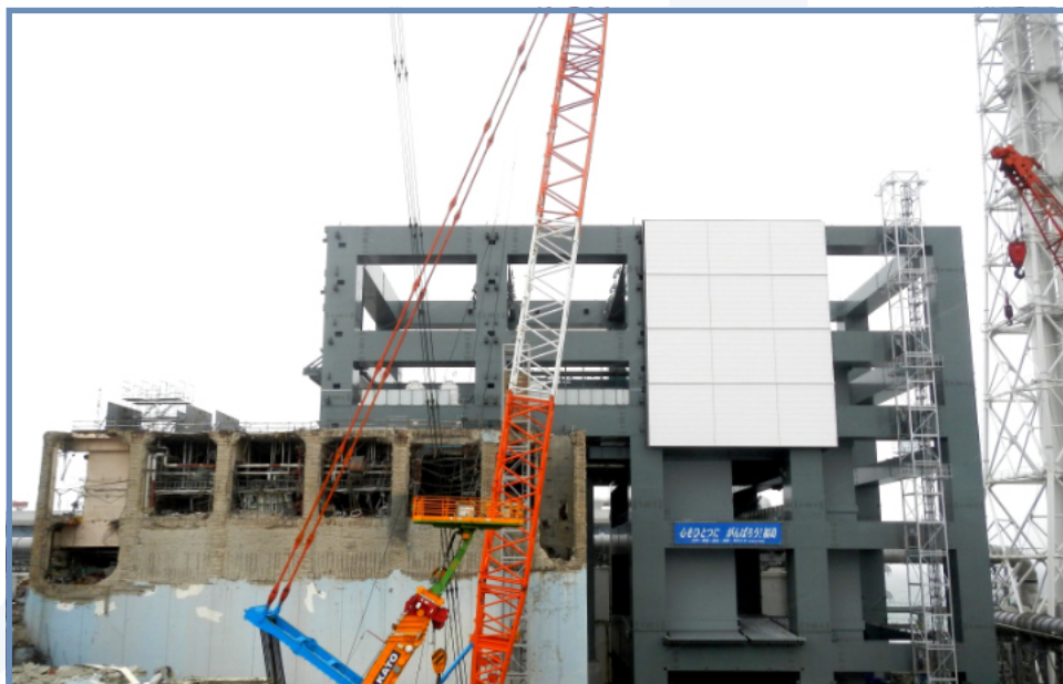
Figure 31. Tranche n° 4 avec la mise en place des installations permettant le retrait des combustibles de la piscine, le 29 mai 2013 (Crédit : Tepco)
