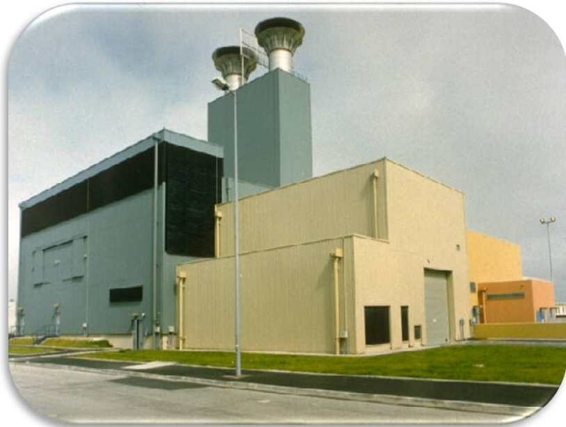
Entreposage des colis vitrifiés, Areva
